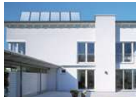
Installazione sopra tetto
