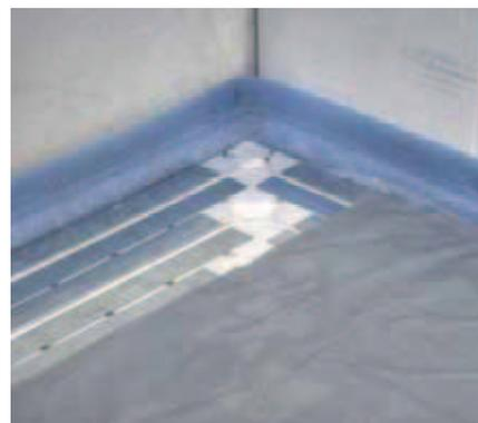
4) In die fertig verlegten Wärmeleitlamelle WLB 14 das Heizrohr (Ø 14 mm) einfach mit dem Fuß fixieren.
