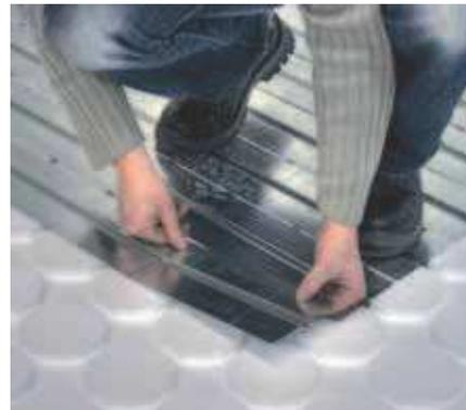
1) TBS - Strukturplatte in einer Raumecke beginnend fugendicht unter die Folienschürze des Randdämmstreifens verlegen.
